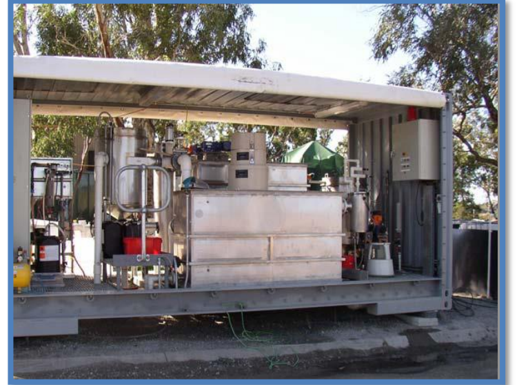
ا-منظومة معالجة المياه الرمادية
