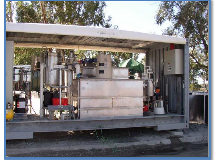
ا-منظومة معالجة المياه الرمادية
