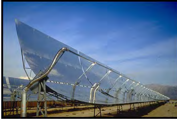
شكل (٧-١) استخدام الاشعة الشمسية لتسخين المياه (غرين سبيس-١٩٩٢).
