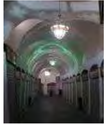
الممرات المسقفة بعد عمليات الترميم
