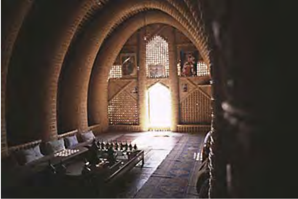
نموذج لاستخدام مواد البناء المحلية ( القصب والبردي ) في الاهوار
