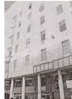
شكل (١٣) عمارة الدامرجي
